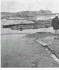
南相馬市鹿島区八沢地区での排水作業
