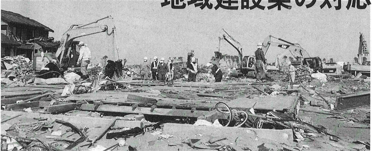
仙台市若林区荒浜地区でがれきの撤去を進める建設業者 (6月13日、撮影/建設新聞社・宮城)
