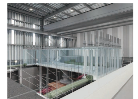
制御・計測室から試験機を見る
