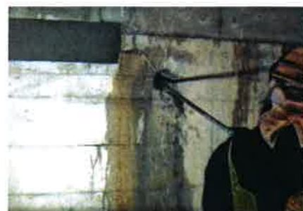
写真3 ■ 点導水工法で施工の様子。滞水している箇所に向けて、どの方向に削孔するかは「トンネル屋」の勘で見極める(写真:寿建設)
