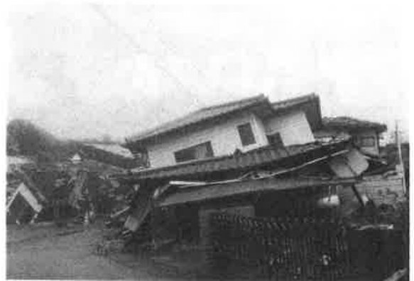
熊本県益城町の崩壊した木造住宅、平成28年4月25日米田撮影
