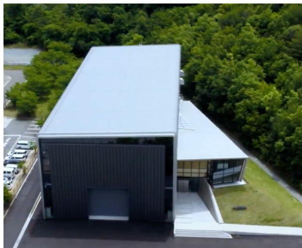
写真1 兵庫県三木市に完成した実大免震試験機 (E-Isolation)
