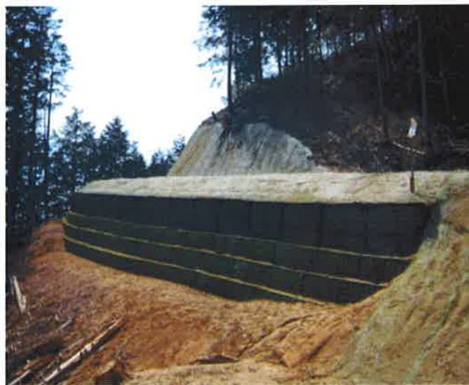
鋼製土留工の施工事例(京都府)
