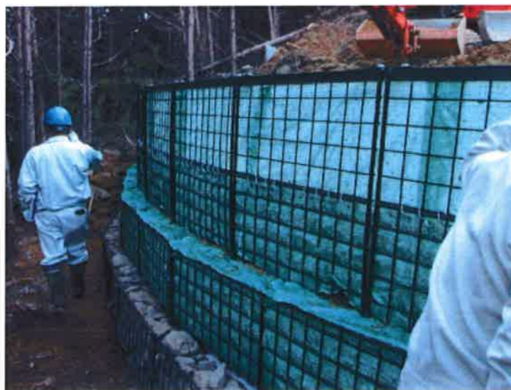
鋼製土留工の施工事例(京都府)
